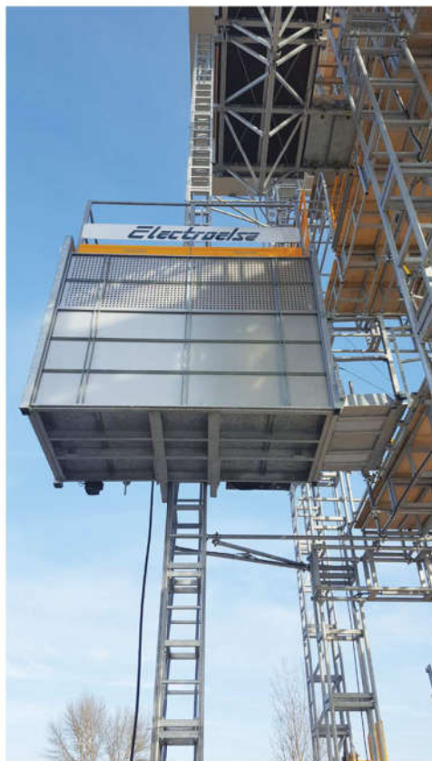
Construction hoist Ascensore da cantiere ELSA H20
